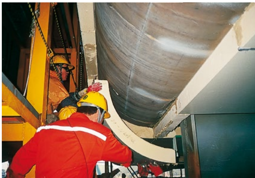
Izolace potrubí z vysoce účinného izolačního materiálu polyuretanu – kvalitní izolace při extrémně nízkých i vysokých teplotách.
