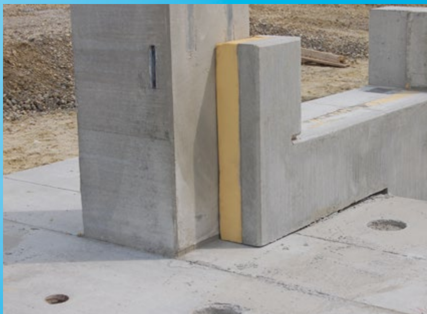
Pro výstavbu průmyslových hal: Betonový prvek s integrovanou PIR izolací.
